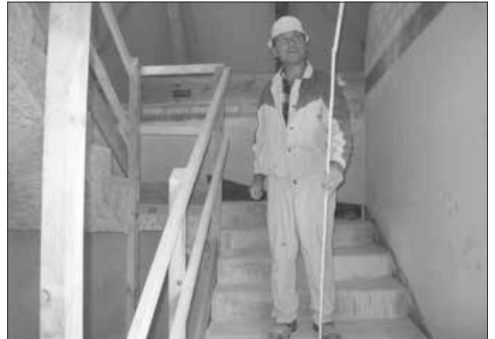
– Gemeindearbeiter Heinz Schnell hat schon viel Vorarbeit geleistet
