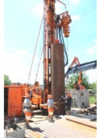
Zum Schutz der bestehenden Ausbaurohrung und zur Absicherung des Bohrloches werden derzeit verschiedene Stahl-Überschubrohre durch eine Brunnenfachfirma eingebracht. Der obere Bereich des Brunnens muss fachgerecht stabilisiert werden um ein Einstürzen zu verhindern.
