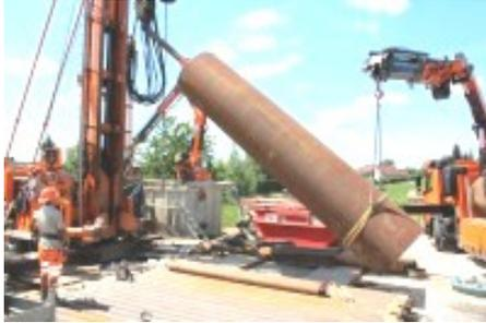
Aufgrund unvorhersehbarer Ausbau- und Stabilitätsprobleme durch nachfallendes Gebirge am Bohrloch, erschweren und verzögern sich die Sanierungsarbeiten am Brunnen 1.
