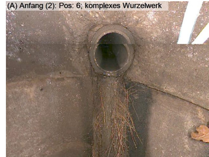
Schacht HO18 – „Hohlweg“
