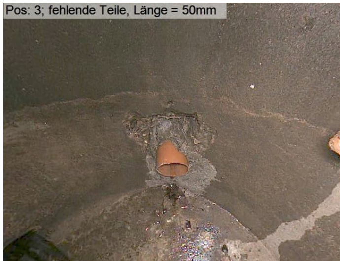
Schacht HO11R – am RÜB
